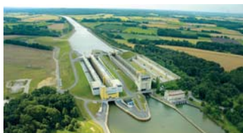
Esterholz – Schleuse Uelzen
